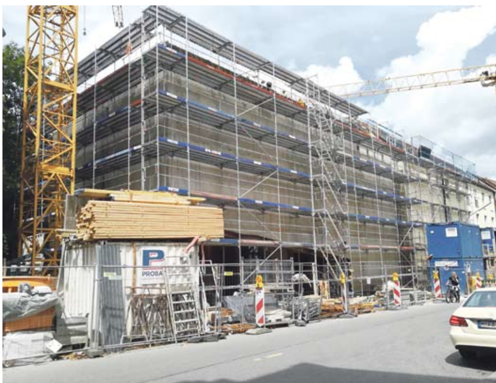
Der Rohbau des Sudetendeutschen Museums in der Münchener Hochstraße nimmt Gestalt an.
